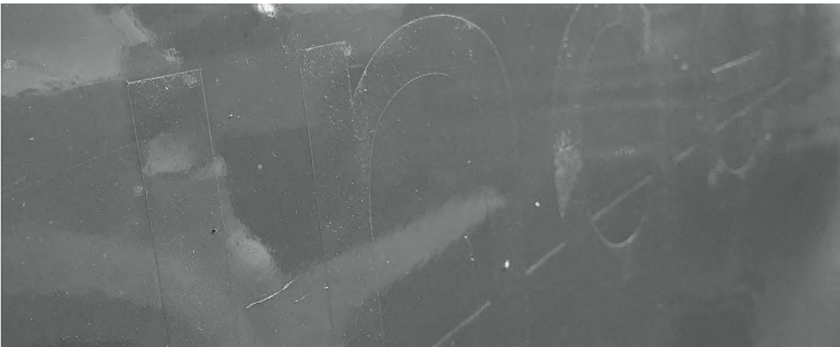
Oštećenje farbe usljed naljepnica
